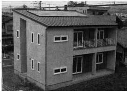
外壁は南九州シラス台産の火山灰を用いた「白州そとん壁」
